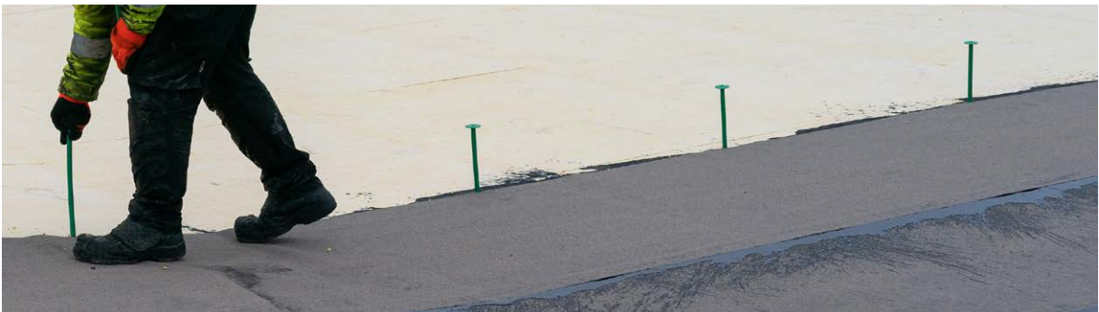
Eristeiden sekä vesikatemateriaalin kiinnitys mekaanisin kiinnikkein.
